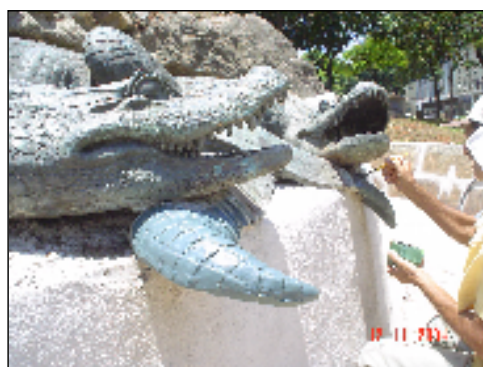
Figura II.6- Aplicação do revestimento [33] .
