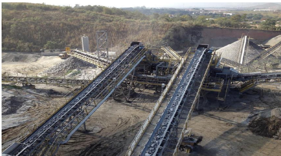
Figura 3.2 – Parte da usina de processamento: Correias da saída dos britadores primários alimentando peneiras de dois deques que alimentam o secundário e a pilha de bica corrida
