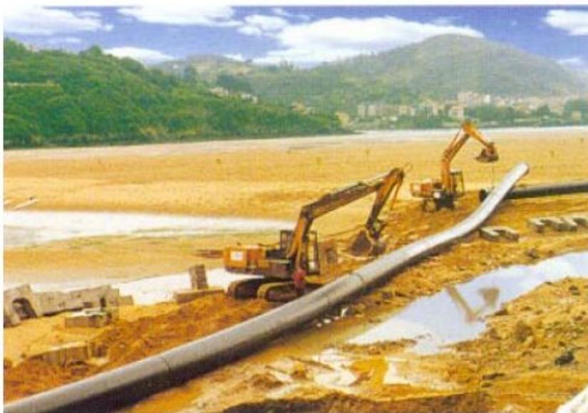
Figura 11 - Instalação de duto de PEAD [22].
