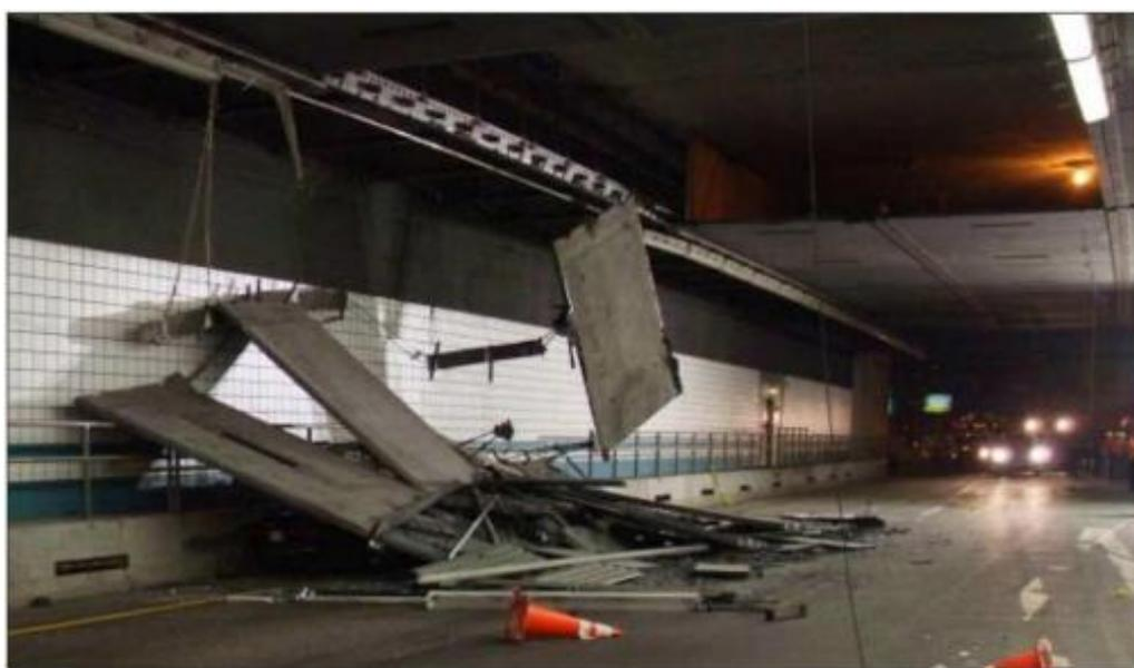
**Figura 13 - Falha catastrófica em função da fluência de resina epóxi usada para ancoragem de parafusos em painéis de concreto [25].**
