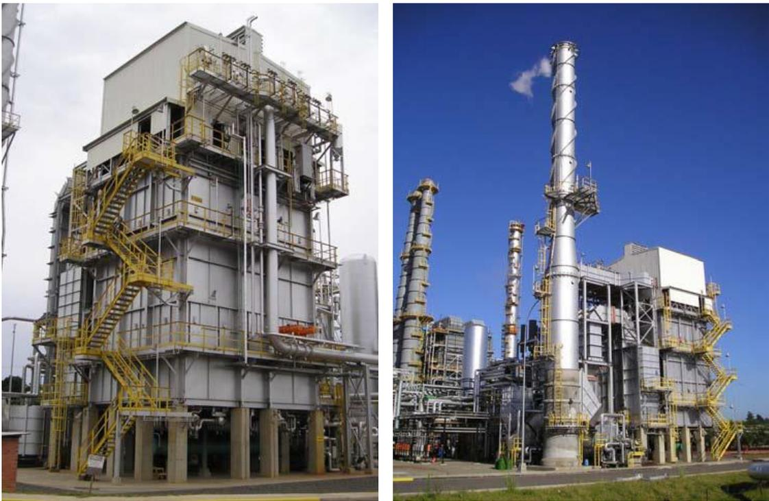
Figura 41: Forno reformador com múltiplas fileiras de tubos verticais [62].
