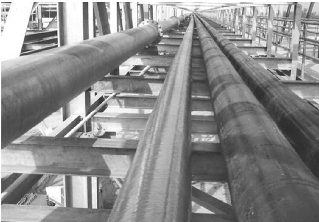
**Figura 1: Tubulação de compósito de fibra de vidro com matriz polimérica (NOV, 2011).**
