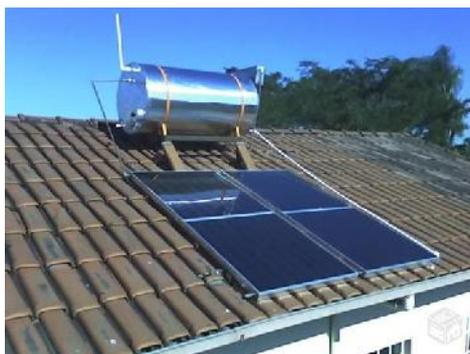
**Figura 12. Sistema fototérmico caseiro de placa plana para aquecimento de água.**
