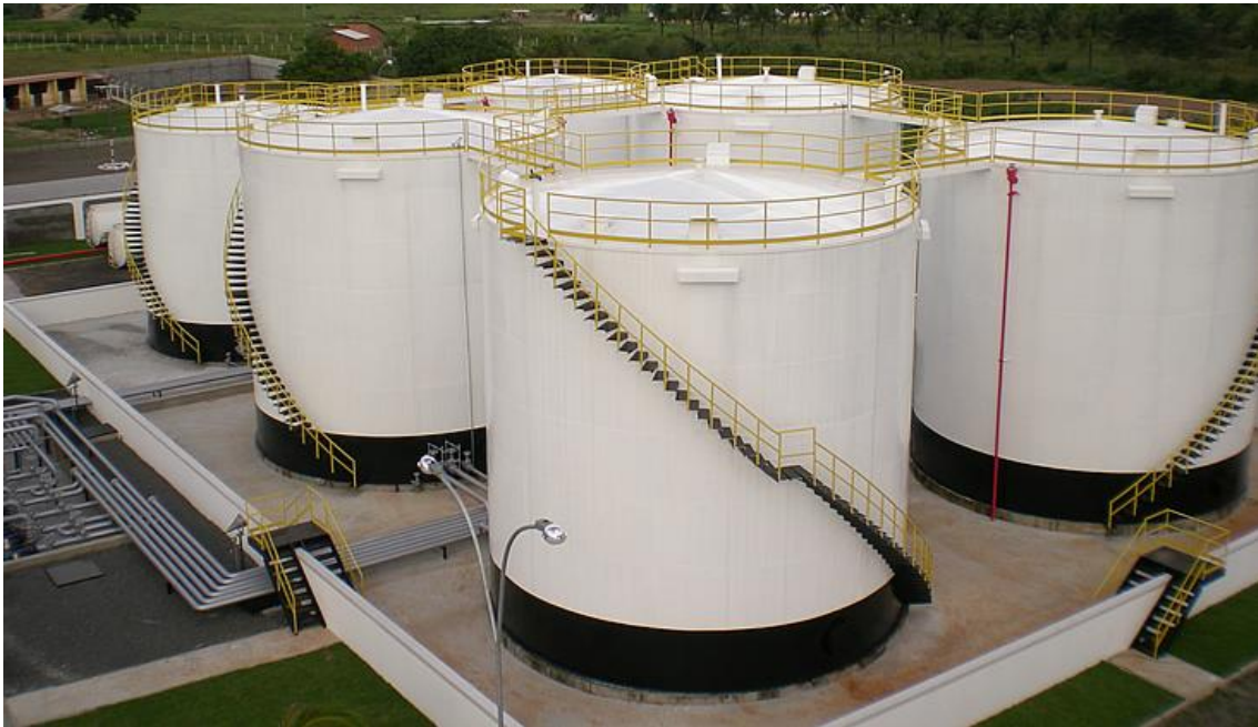
Figura 4 – Tanque de Armazenamento de Petróleo
