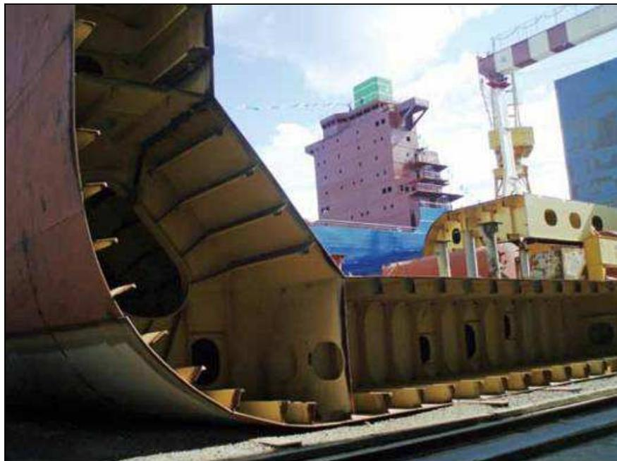
**Figura 3** - Anel do bloco de aço estrutural para construção do navio.
