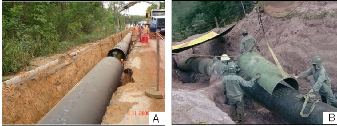
Figura 5 – (a) Substituição dos dutos e (b) Dupla Calha Soldada. (NCPAN, 2010)
