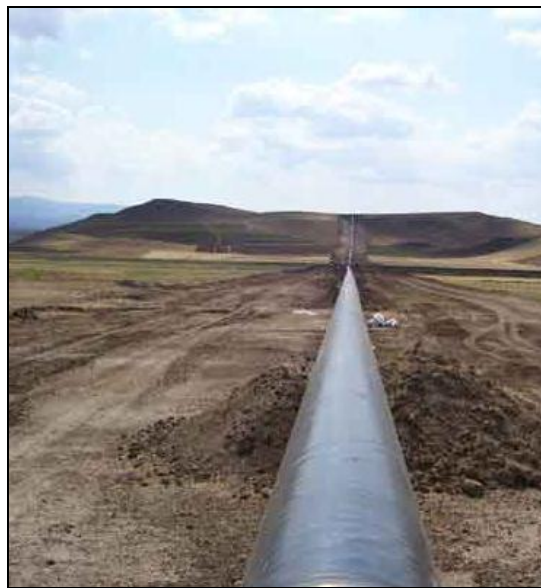
Figura 2 – Duto terrestre (Peker, 2010).
