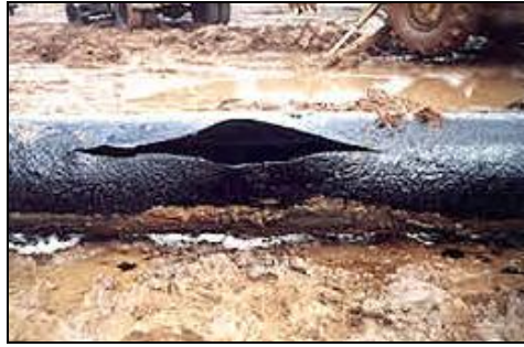
Figura 4 – Oleoduto rompido por corrosão. (CETESB, 2010)
