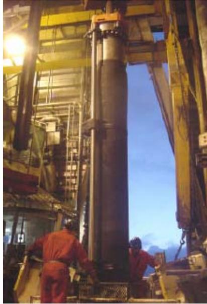
**Figura 21** – Instalação do *riser* fabricado na plataforma TLP Heidrun (Storhaug *et al*, 2001).
