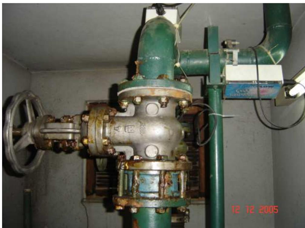
**Fig 34** – Instalação do equipamento comercial Hydroflow na tubulação de água logo após a bomba.
