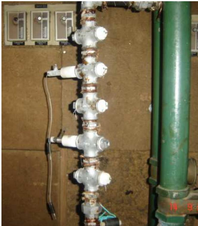
**Fig 35** – Montagem do sistema *by pass* em tubos de aço carbono diâmetro 1” na saída do condensador nº03 em paralelo com a tubulação principal.
