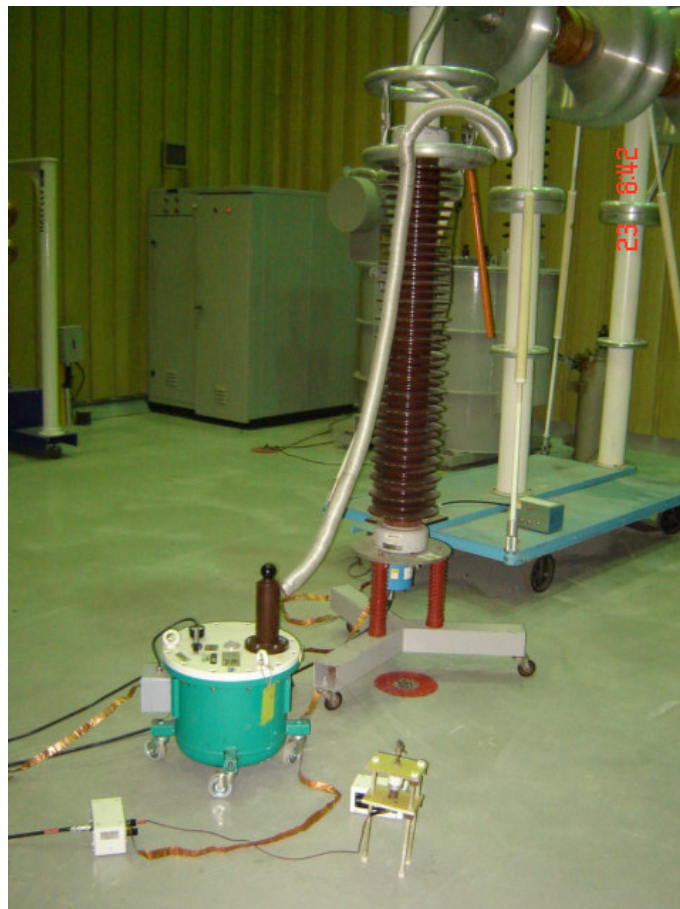
Figura 29 – Detalhe do arranjo de ensaio utilizado para a medição da capacitância e tangente de perdas ( \delta ). Laboratório de Ensaio Corona (AT2) da DVLA – CEPEL.
