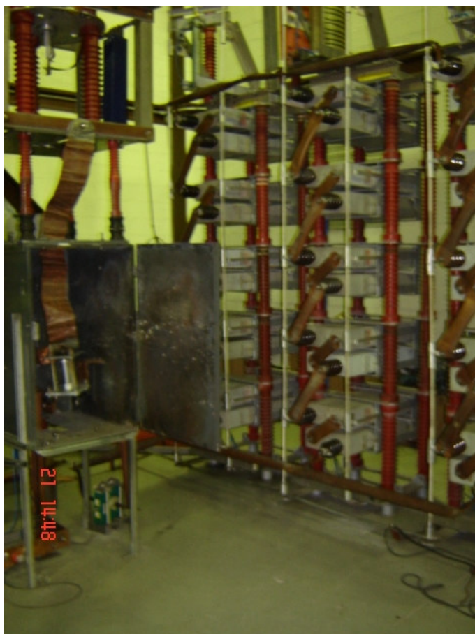
Figura 37 – Arranjo do circuito utilizado para o ensaio por ciclos de impulsos de corrente atmosféricos. Laboratório de Impulso de Corrente (AT4) da DVLA – CEPEL.
