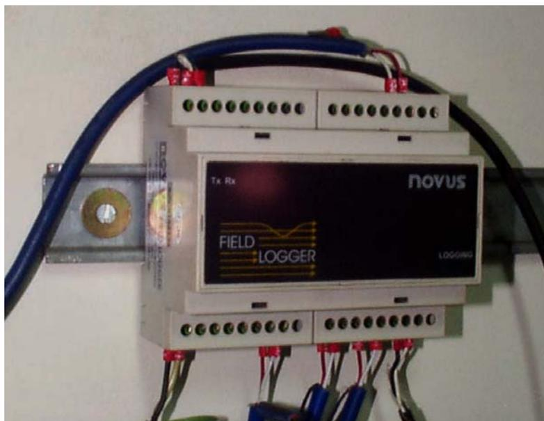
Figura 49: Sistema de monitoração e captura contínua de dados (*Field logger*).
