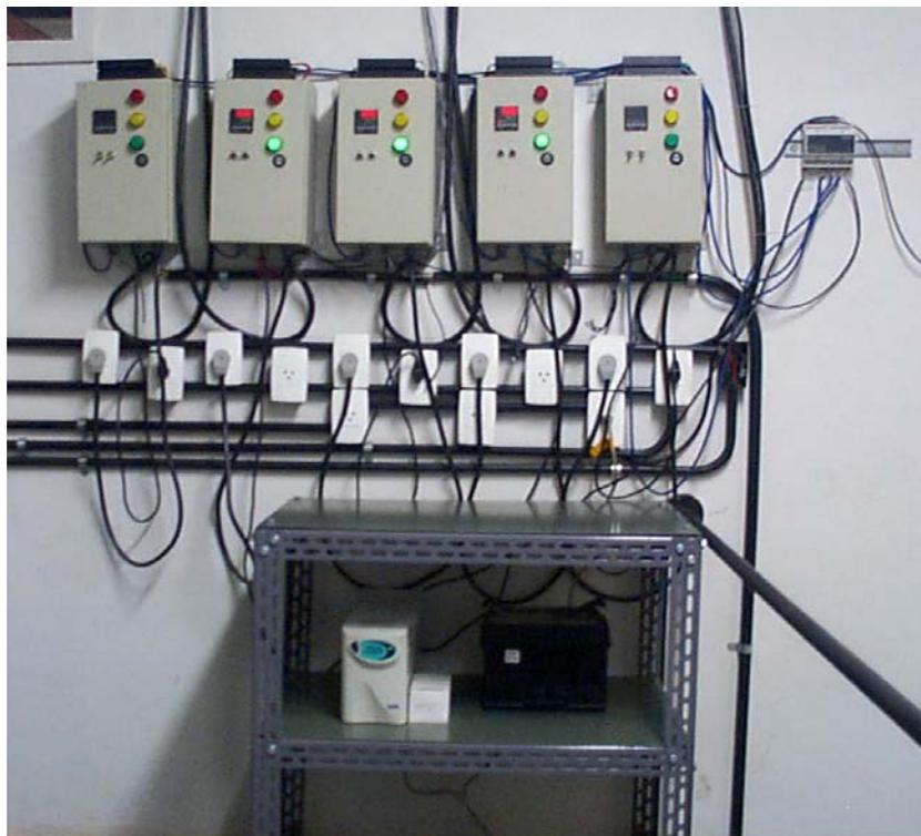
Figura 48: Conjunto de controladores digitais para controle dos cinco fornos.
