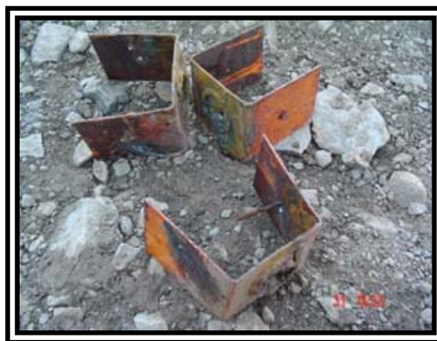
Figura 15 - Apoios constituídos de chapas de aço-carbono onde são posicionados alguns módulos.
