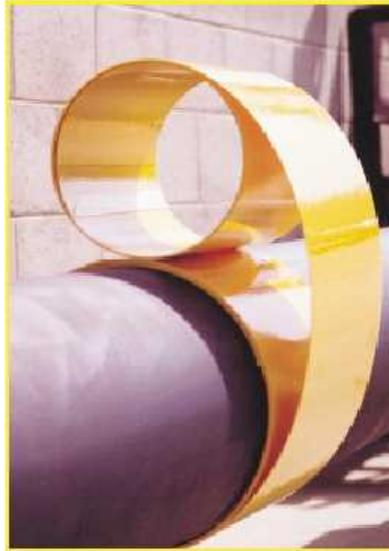
Figura 2.28: Reparo com compósito através de seções pré-fabricadas [60].
