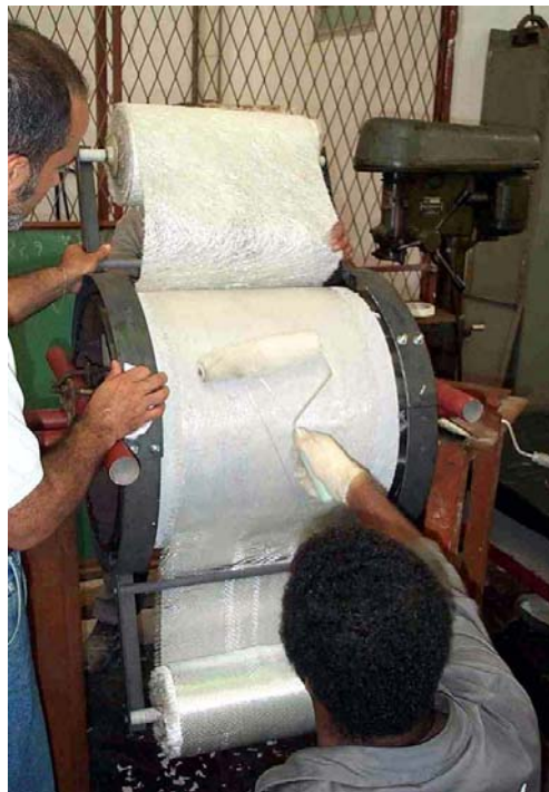
Figura 2.3 - Reparo por Compósitos, Laminação in situ . [19].
