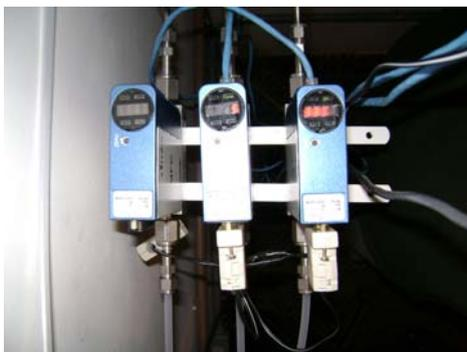
Figura 43 – Fluxímetros (Ar, CH<sub>4</sub> e H<sub>2</sub>)
