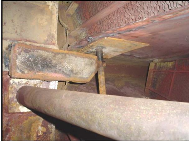
**Figura 1.4** – Interior do PAF/REDUC, mostrando corrosão generalizada em toda superfície metálica.
