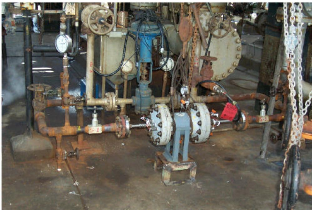
Figura 12 – Célula Multitest instalada em uma refinaria.
